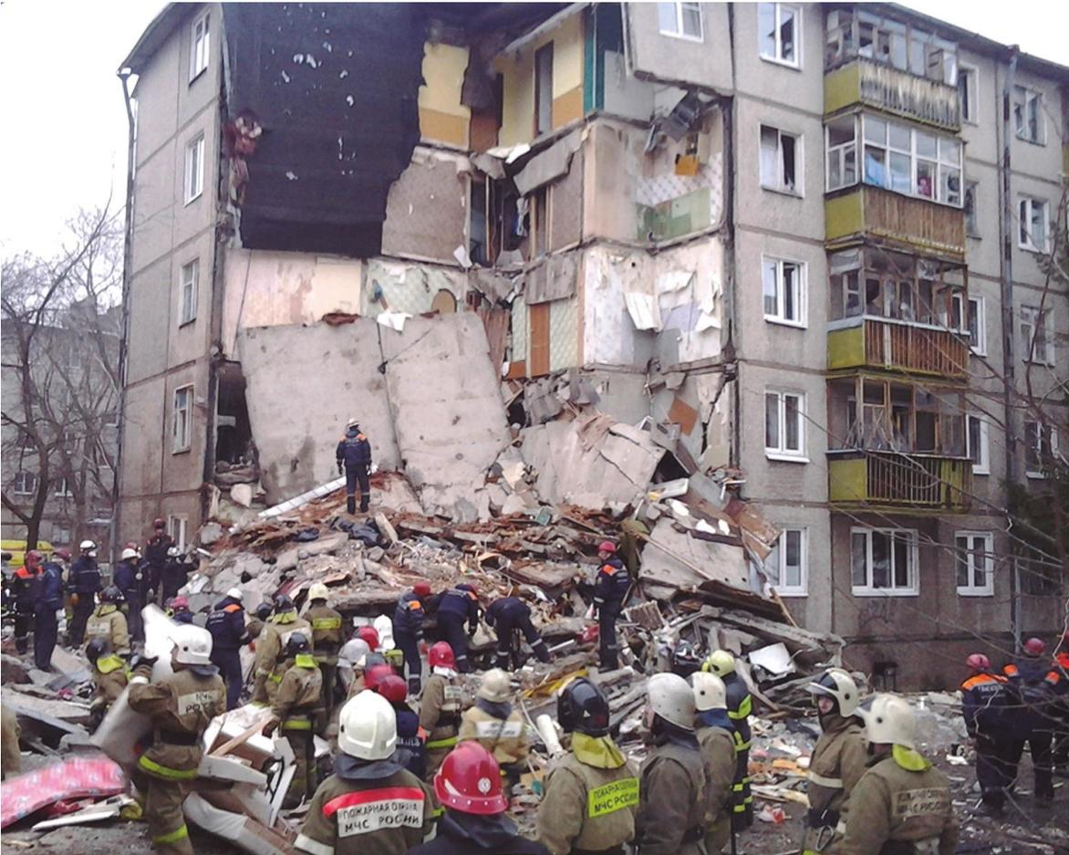
Edificio destruido por explosión por combustión por gas.
