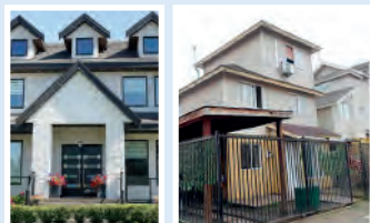
Techo de edificación de tres pisos
