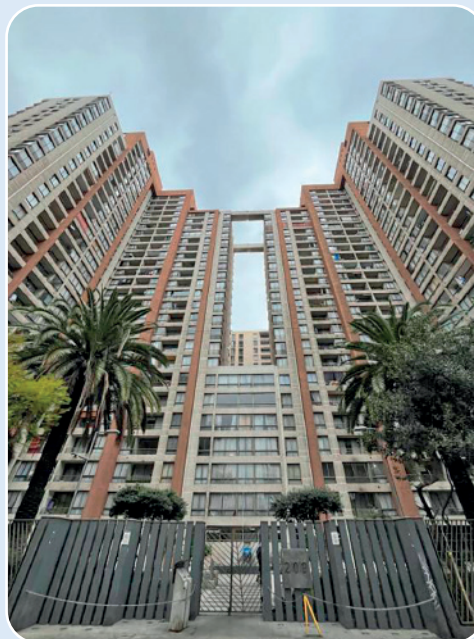
EDIFICIO DE DEPARTAMENTOS
